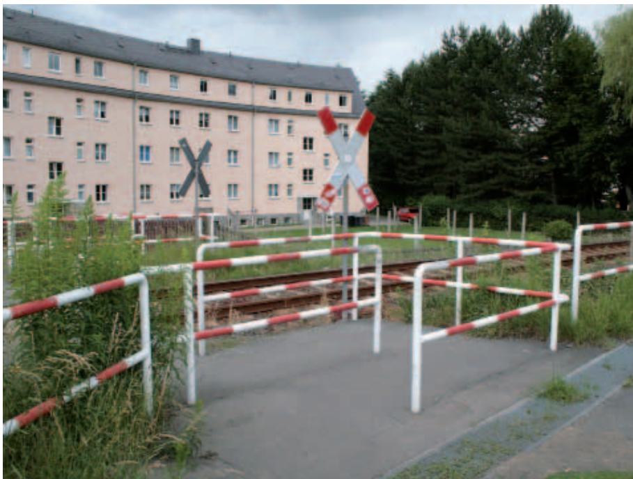
Abb. 1: Ausführungsbeispiel einer Umlaufsperrre
