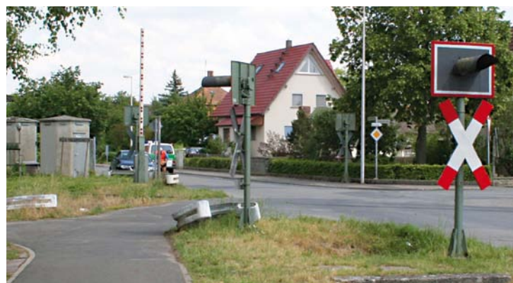
Abbildung 3: Fehlende Sicherungseinrichtungen für Fußgänger
