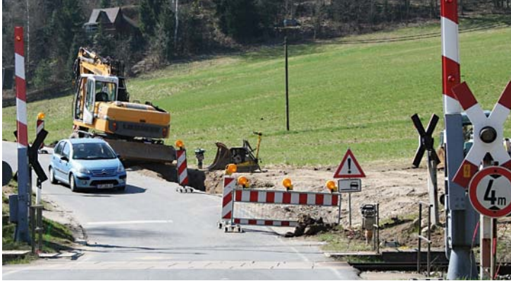
Abbildung 5: Einschränkung der Fahrbahnbreite durch eine Baustelle
