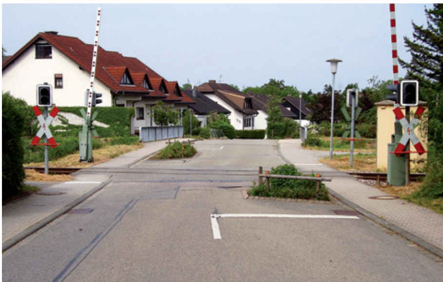
Abb. 1: Auswirkungen einer unzureichenden Abstimmung zwischen Straße und Schiene Foto: Gunnar Bosse
