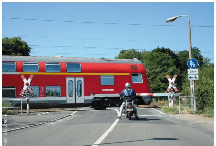
Abbildung 3: Fußgänger müssen vor dem Bahnübergang auf die andere Straßenseite wechseln. Dadurch können sie vom Straßenverkehr gefährdet werden, außerdem gibt es bei dieser Bestandsanlage keine Fußgängerschranke
