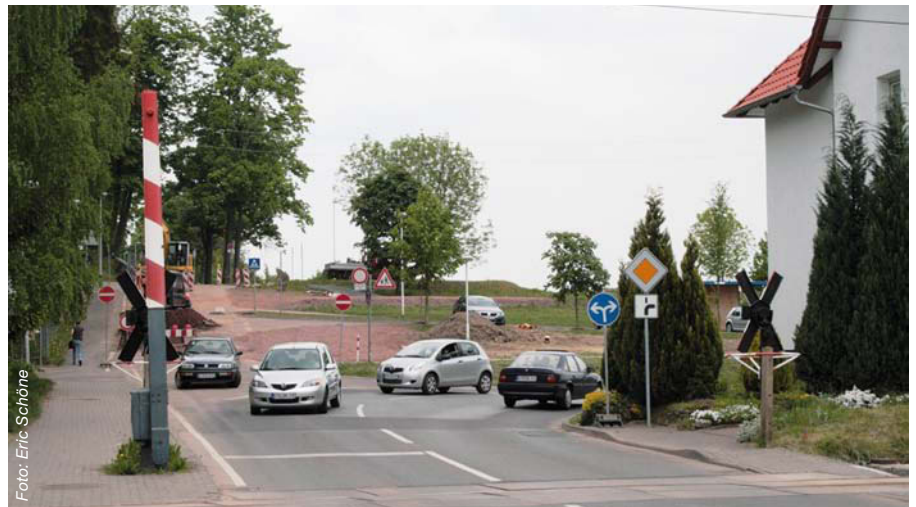
Abbildung 2: Ungünstige Vorfahrtregelung im Räumstreckenbereich, wodurch nach links abbiegende (bzw. nach Ende der Bauarbeiten auch geradeaus fahrende) Lkw den Bahnübergang nicht vollständig räumen können
