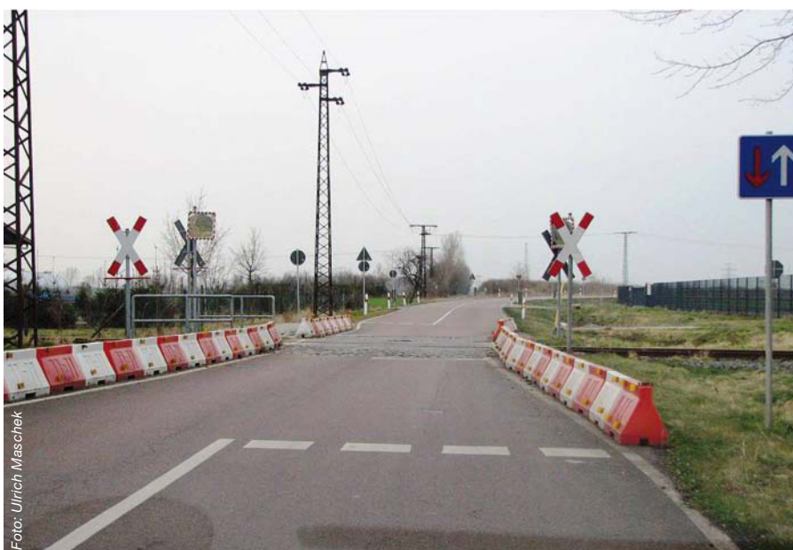
Abbildung 1: Verringerte Fahrbahnbreite im Bahnübergangsbereich und Lösungsversuch durch Gegenverkehrsregelung. Nebenbefund: Unzulässiger Einsatz von Verkehrsspiegeln
