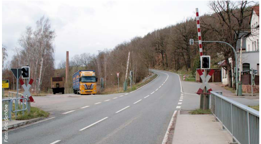
Abbildung 6: Bahnübergang im Zuge einer stillgelegten Eisenbahnstrecke. Die straßenseitige Ankündigung und die Gleise wurden bereits beseitigt, die Sicherungseinrichtungen sind jedoch noch vollständig vorhanden
