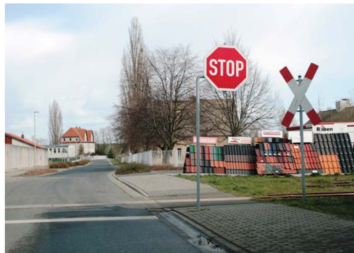
Abbildung 12: Unzulässige Kombination des Andreaskreuzes mit dem Stoppschild, Foto: Schöne.
