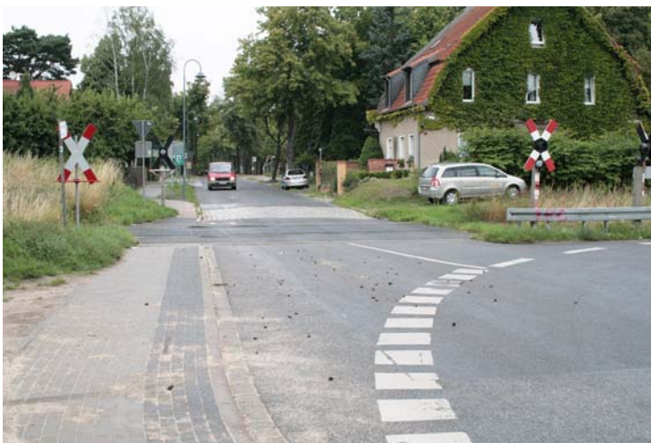
Abbildung 10: Blinklichtanlage mit ergänztem Andreaskreuz auf der linken Seite, wodurch insbesondere für Fußgänger und auf dem Gehweg radfahrende Kinder Unklarheit über den Charakter des Bahnübergangs bestehen kann, Foto: Schöne.
