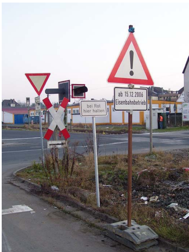
Abbildung 11: Durch den hier vorzufindenden „Schilderwald“ können die wichtigen Einrichtungen wie Andreaskreuz und Blinklicht leicht übersehen werden, Foto: Hunger.
