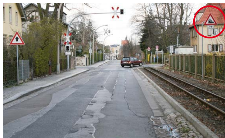
Abbildung 3: Das rechts stehende Gefahrzeichen ist kaum wahrnehmbar, was aus dem zu großen Abstand vom Fahrbahnrand und der gleichzeitig linksseitigen Aufstellung eines Vorfahrtszeichens resultiert. Außerdem befindet sich das Zeichen in zu geringer Entfernung vor dem Bahnübergang, Foto: Schöne.
