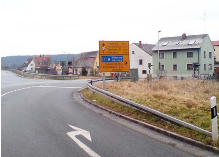
Abbildung 9: Das rechts der Fahrbahn aufgestellte Andreaskreuz mit Blinklicht wird fast vollständig vom Wegweiser verdeckt und ist somit wirkungslos, Foto: Hunger.
