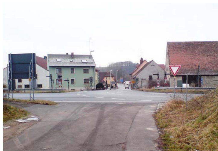
Abbildung 8: Drei von vier Richtungen der Straßenkreuzung wurden in die Bahnübergangssicherung einbezogen. Für die vierte Fahrtrichtung sind weder Andreaskreuze noch entsprechend ausgerichtete Blinklichter vorhanden, Foto: Hunger.
