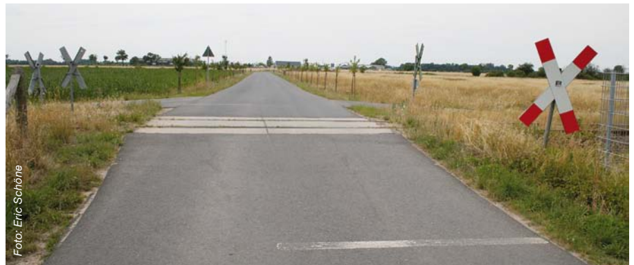
Abbildung 1: Bahnübergang ohne technische Sicherung an einer stillgelegten Strecke
