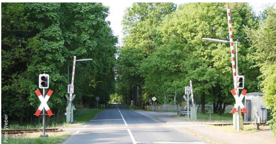
Abbildung 5: Sicherung eines Bahnübergangs durch Lichtzeichen mit Halbschranken
