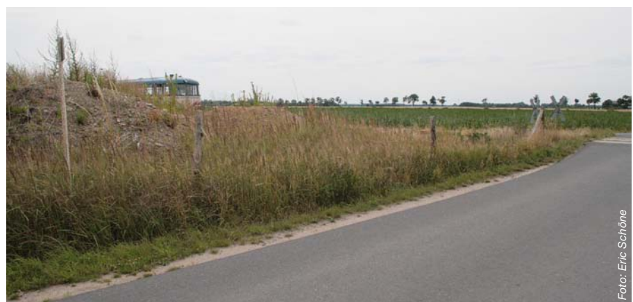
Abbildung 4: Abgelagerter Erdaushub als Hindernis in der Sichtfläche
