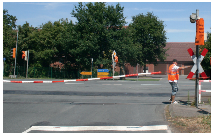
BILD 2: Vorübergehende Postensicherung als Ersatz für eine ausgefallene technische Sicherung (Foto: Schöne)
