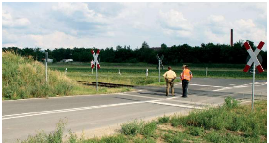
Abb. 1: Zur Bahnübergangsschau gehört die Beurteilung der vorhandenen Sichtverhältnisse.
